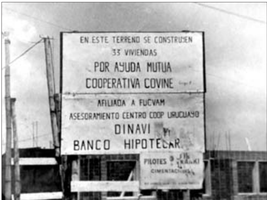
Cartel DINAVI en la obra de COVINE 1 en calle Timote, Nuevo París, 1970
